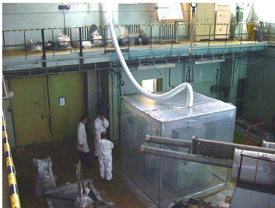
5.1. attēls. Plastikāta telts kodolreaktora zālē radioaktīvo detaļu sadalīšanai
