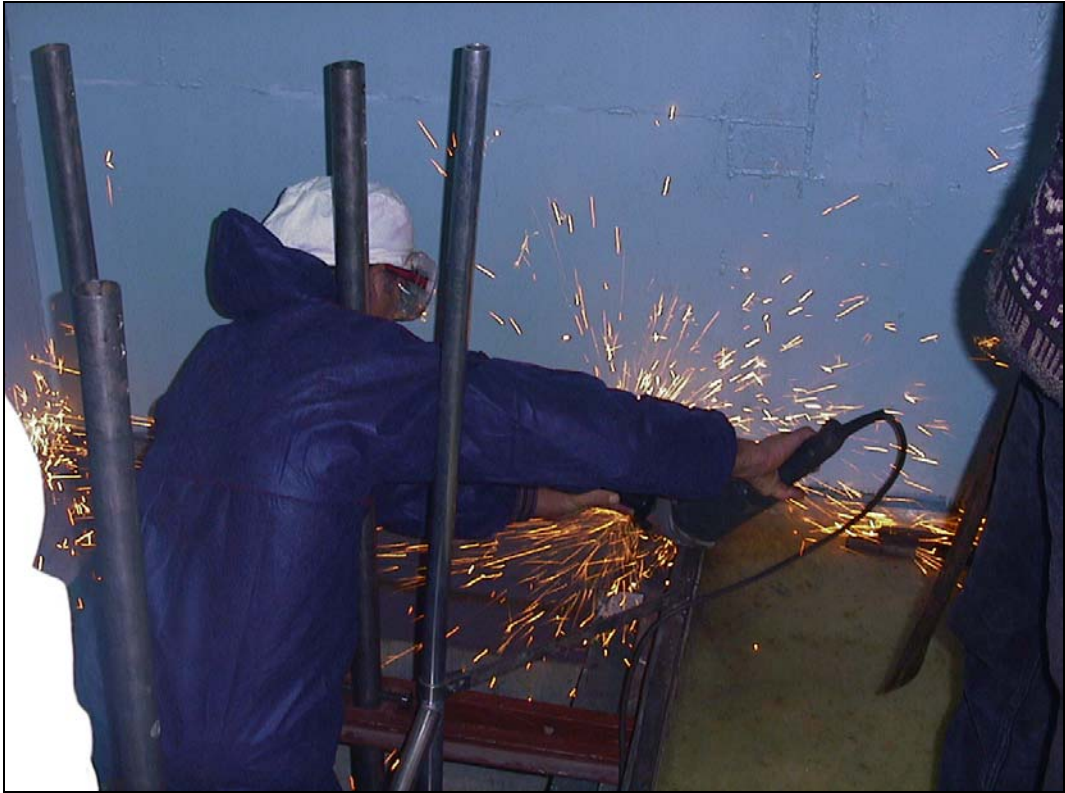
3.2. attēls. Demontāžas darbi, izmantojot abrazīvo slīpripu
