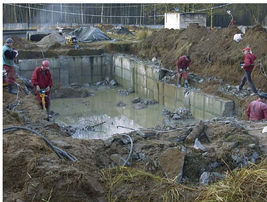
5.6. attēls. Otrā dzesēšanas kontūra sūkņu stacijas pamatu demontāža
