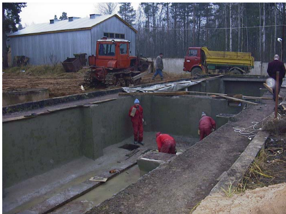
5.9. attēls. Dzesēšanas torņa baseina hermetizācijas darbi
