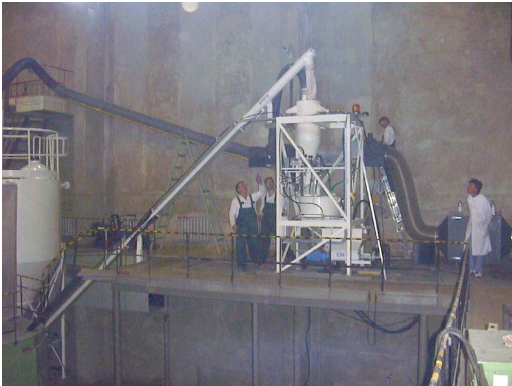
4.5. attēls. Radioaktīvo atkritumu cementēšanas iekārta “Betons-25”
