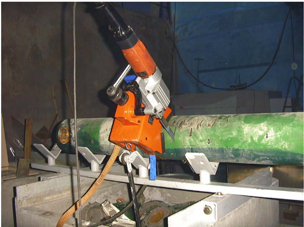
3.3. attēls. Radioaktīvo detaļu sadalīšana, izmantojot pendelzāģi
