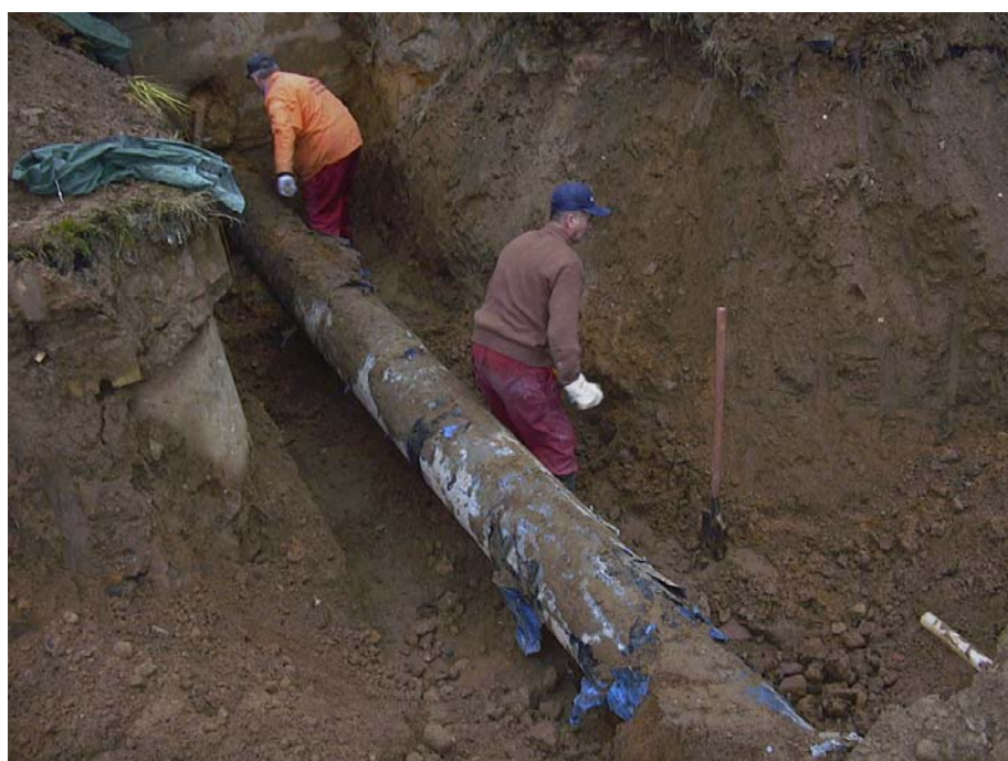
5.8. attēls. Otrā dzesēšanas kontūra cauruļvadu demontāža
