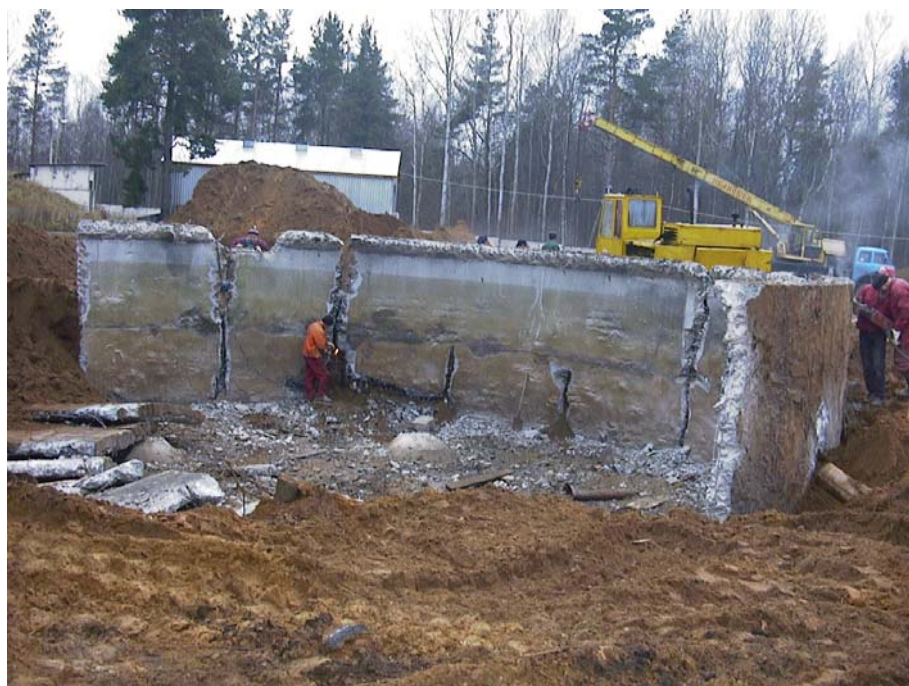
5.7. attēls. 400 m 3 betona rezervuāra demontāžas darbi
