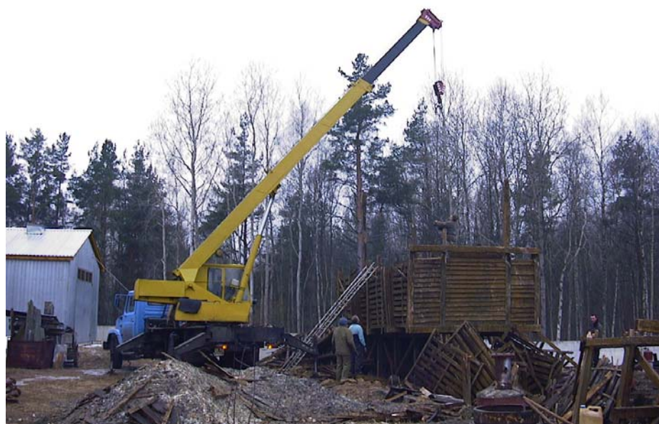
5.5. attēls. Otrā dzesēšanas kontūra torņa nojaukšana
