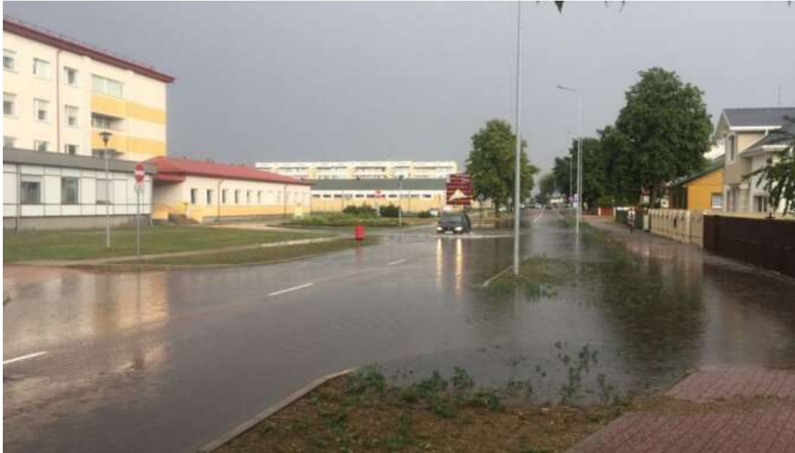
6.3.2.1.1.attēls. Plūdi Ventspilī Inženieru ielā 2018. gada 31. jūlijā ( https://www.delfi.lv )
