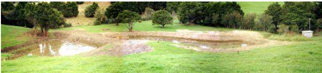
4.2. attēls. Nesen izbūvēts mākslīgais mitrājs difuzās noteces attīrīšanai, fotogrāfija 34
