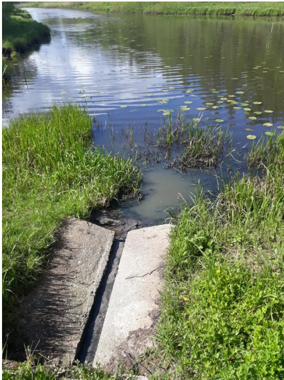
Neattīrītu notekūdeņu izplūde pirms notekūdeņu iekārtu uzstādīšanas.
