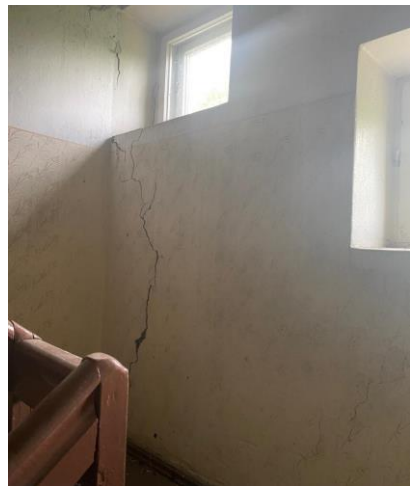
Skats uz ēkas iekštelpām – 2. stāva tualetes telpām un ēkas sienu fragmentu/plaisas/.
