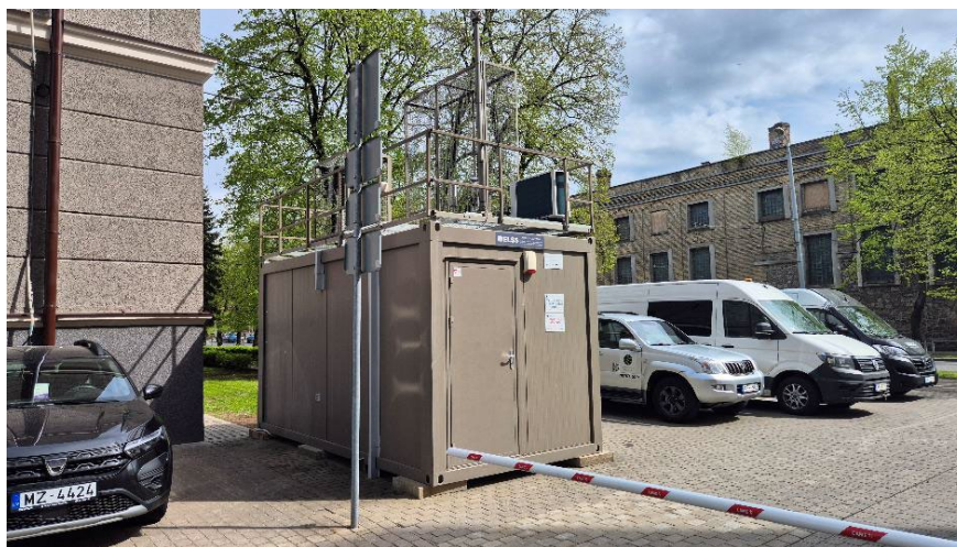
3.15. attēls. Stacija Rīga-Valdemāra iela 65 kontainers
