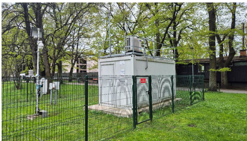
3.4. attēls. Stacija Rīga-Kronvalda bulvāris konteiners, Kronvalda bulvārī 4
