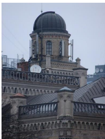
3.4.2.2. attēls. Stacija Rīga-Parks, LU ēka Raiņa bulvārī 19
