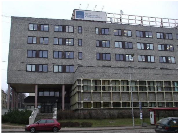
3.4.1.2. attēls. Stacija Rīga-Ķengarags, LVGMC ēka Maskavas ielā 165
