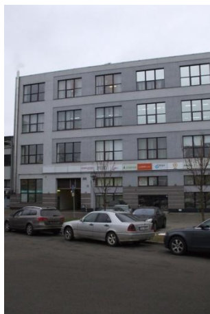
3.4.1.4. attēls. Stacija Rīga-Ķengarags, SIA „DL Timber Products” ēka Mazā Krasta ielā 83
