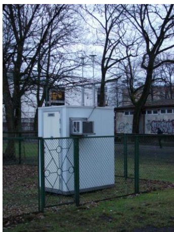
3.4.3.2. attēls. Stacija Rīga-Kronvalda bulvāris konteiners, Kronvalda bulvārī 4
