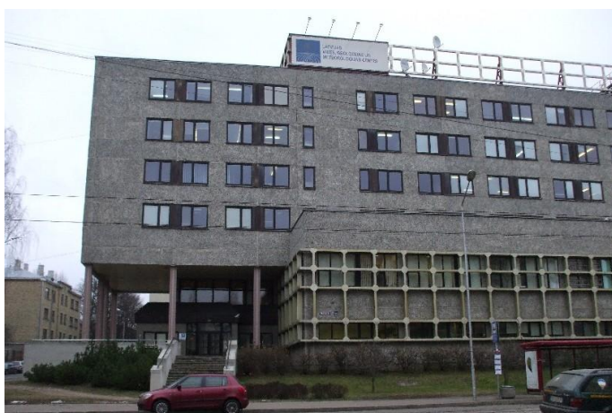
4.3.1.2. attēls. Stacija Rīga-Ķengarags, LVGMC ēka Maskavas ielā 165
