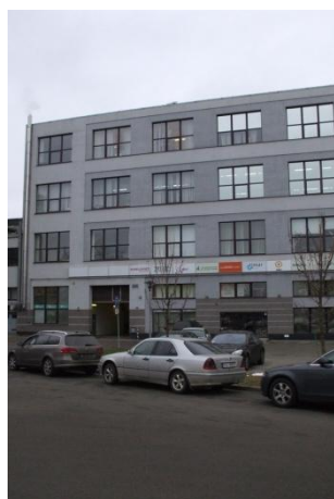
4.3.1.4. attēls. Stacija Rīga-Ķengarags, SIA „Timorsēkas” ēka Mazā Krasta ielā 83
