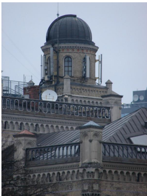
4.3.2.2. attēls. Stacija Rīga-Parks, LU ēka Raiņa bulvārī 19
