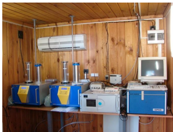
4.4.1.3. attēls. Stacijas Liepāja-Kalpaka iela mēraparatūra konteinerā
